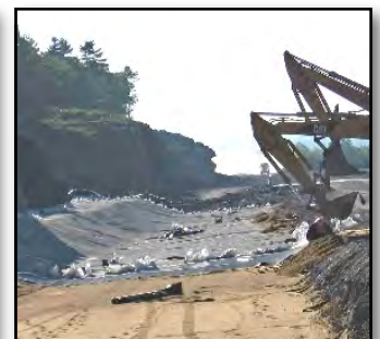
IMPERMÉABILISATION DE FOSSE
